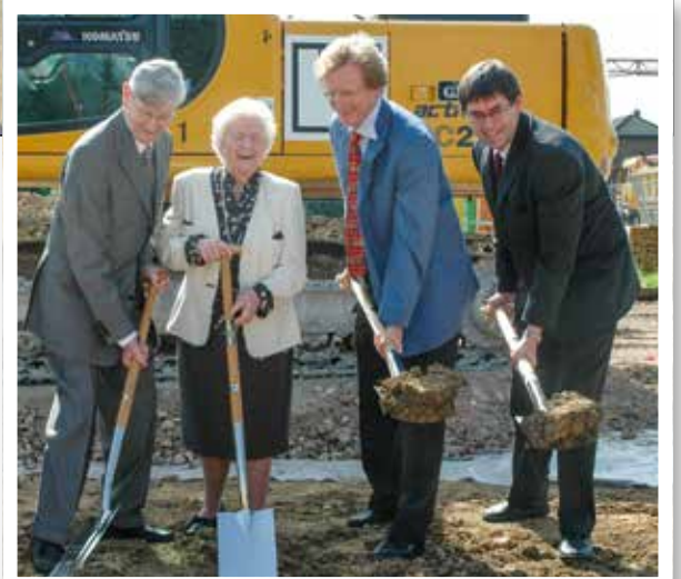
Familie Schroeder beim Spatenstich für den Erweiterungsbau rechts oben
